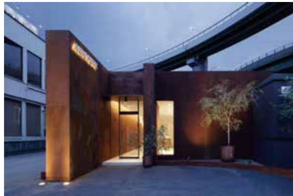
「VeroMetal®」の金属塗装による赤サビの外壁面と内壁面
